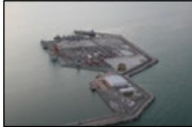
Se localiza en la Terminal remota, protegiéndola. Mide 1,611 m de largo, corona de 4 m de ancho y 5 m de altura, está construida de piedra y cubos de concreto de 10.2 ton.
