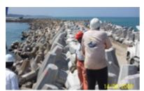
En Puerto de Tuxpan se cuentan con 2escolleras y espigones, a fin de minimizar la erosión que produce el alto oleaje característico del Puerto.
