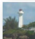
BALIZA PUNTA CAZONES AL NORTE DE LA BARRA DE CAZONES, se ubica en situación geográfica (20° 28' 28.92" N, 97° 00' 56.42"), 2 D.B. Período 10.0 seg. Luz 1.0 Ec 2.0 Luz 1.0 Ec 6.0, Torre troncopiramidal metálica de 11.0 mts. de altura color blanco Linterna de 300 mm. Sistema fotovoltaico.
