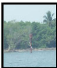
**Baliza Isla La Azteca(Marca la entrada al puerto de Frontera).-** (18° 36.05'N; 092° 41.73'W). Estructura tubular metálica color rojo, de 3 m de altura, características luminosas: 12 D.R.P.M. período de 5 seg., (Luz 1.0 seg., Ec. 4.0 seg.), alcance geográfico de 5 M y luminoso de 4 M.
