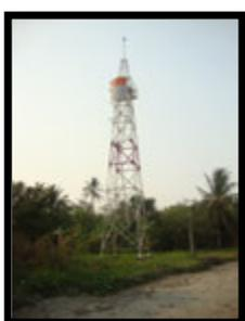
**Baliza Enfilación Posterior Marca el Eje de entrada del canal de la barra.-** (18° 35.5'N; 092° 41.2'W). Es una torre piramidal metálica color blanco de 17 mts de altura, características luminosas: 20 D.B.P.M. período de 2 seg., (Luz 1.0 seg., Ec. 1.0 seg.), alcance geográfico de 5 M y luminoso de 4 M.
