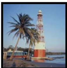
**Faro la Barra.-** (18° 36.77'N; 092° 41.32'W), torre metálica de 8 columnas, blanca de 29m de altura, visible del 045° al 245°; características luminosas 10 D.B.P.M. período de 6 seg., (Luz 1.0 seg., Ec. 5.0 seg.) alcance geográfico de 15 M y luminoso de 14M.
