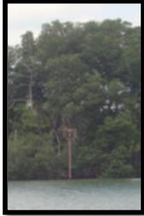
**Baliza Isla Punta del Buey(En el canal de navegación).-** ( $18^{\circ} 34.52'N$ ;  $092^{\circ} 41.22'W$ ). Estructura tubular metálica color rojo, de 3 m de altura, características luminosas: 20 D.R.P.M. período de 3 seg., (Luz 0.5 seg., Ec. 2.5 seg.), alcance geográfico de 4 M y luminoso de 3 M.
