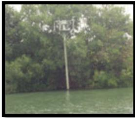
**Baliza de Situación.-** ( $18^{\circ} 34.18'N$ ;  $092^{\circ} 40.57'W$ ). estructura tubular metálica color verde, de 3 m de altura, características luminosas: 20 D.V.P.M. período de 3 seg., (Luz 0.5 seg., Ec. 2.5 seg.), alcance geográfico de 4 M y luminoso de 3 M.
