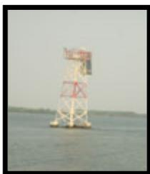
**Baliza Enfilación Anterior Marca el Eje de entrada del canal de la barra.-** (18° 35.65'N; 092° 41.25'W). Es una torre piramidal metálica color blanco de 12 mts de altura, características luminosas: 20 D.B.P.M. período de 3 seg., (Luz 1.0 seg., Ec. 2.0 seg.), alcance geográfico de 5 M y luminoso de 4 M.
