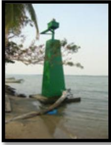
**Baliza Escollera E.-** ( $18^{\circ} 35.12'N$ ;  $092^{\circ} 41.05'W$ ). Torre piramidal de concreto color verde, de 5 m de altura, características luminosas: 12 D.V.P.M. período de 3 seg., (Luz 1.0 seg., Ec. 2.0 seg.), alcance geográfico de 4 M y luminoso de 3 M.
