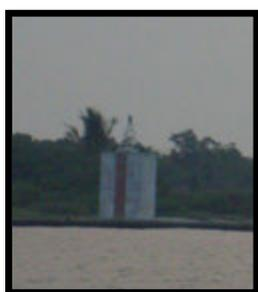
**Baliza Enfilación Anterior al Faro La Barra(marca la entrada al puerto de Frontera).-** (18° 36.8'N; 092° 41.48'W), estructura cuadrada de concreto de 7 m de altura color blanco y franja vertical roja, características luminosas 10 D.V.P.M. período de 5 seg.(Luz 1.0 seg., E.c. 4.0 seg.) alcance geográfico 5 M y luminoso 4 M.
