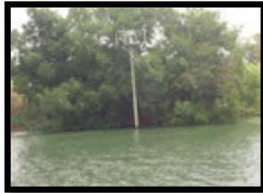
**Baliza de Situación(margen W río Grijalva).**- ( $18^{\circ} 32.5'N$ ;  $092^{\circ} 40.04' W$ ). Estructura tubular metálica color verde, de 3 m de altura, características luminosas: 20 D.V.P.M. período de 3 seg., (Luz 0.5 seg., Ec. 2.5 seg.), alcance geográfico de 3 M y luminoso de 2 M.
