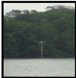
**Baliza Isla Buey(situada en el extremo N de la isla).-** ( $18^{\circ} 33.65'N$ ;  $092^{\circ} 40.56'W$ ). Estructura tubular metálica color verde, de 3 m de altura, características luminosas: 20 D.V.P.M. período de 3 seg., (Luz 0.5 seg., Ec. 2.5 seg.), alcance geográfico de 3 M y luminoso de 2 M.
