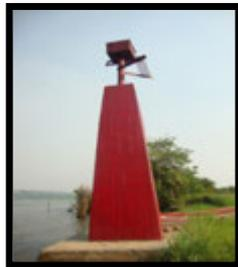
**Baliza de Situación(margen E río Grijalva).**- ( $18^{\circ} 32.29'N$ ;  $092^{\circ} 39.67' W$ ). Torre piramidal de concreto color rojo, de 5 m de altura, características luminosas: 20 D.R.P.M. período de 3 seg., (Luz 0.5 seg., Ec. 2.5 seg.), alcance geográfico de 3 M y luminoso de 2 M.
