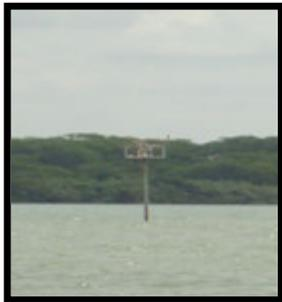
**Baliza Isla Buey(indica el inicio de un bajo).-** ( $18^{\circ} 34.0'N$ ;  $092^{\circ} 40.7'W$ ). Estructura tubular metálica color rojo, de 3 m de altura, características luminosas: 20 D.R.P.M. período de 3 seg., (Luz 0.5 seg., Ec. 2.5 seg.), alcance geográfico de 4 M y luminoso de 3 M.
