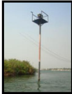
**Baliza Isla Buey(situada en el extremo S de la isla).**- ( $18^{\circ} 33.21'N$ ;  $092^{\circ} 39.69'W$ ). Estructura tubular metálica color verde, de 3 m de altura, características luminosas: 20 D.V.P.M. período de 3 seg., (Luz 0.5 seg., Ec. 2.5 seg.), alcance geográfico de 3 M y luminoso de 2 M.
