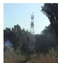
y. Baliza Enfilación Posterior Canal Norte.- (17° 58' 54.06", 102° 10' 16.69") Baliza tipo piramidal construida en aluminio de 10.0 m. Linterna LO-1/LED Sistema fotovoltaico; en período de 6 seg., con alcance geográfico de 15 M y luminoso de 12 M.
