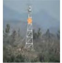
z. Baliza Fertinal S-N- (17° 55' N, 102° 10' W). Poste tubular metálica de 2.50 m de altura color verde, con características luminosas de 1 D.V., en período de 6 seg., con alcance geográfico de 5 M y luminoso de 4 M.
