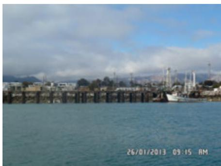
Es un muelle de concreto destinado para embarcaciones comerciales de pesca de camarón y escama, cuenta con columnas con alturas necesarias para permitir diferencias de marea hasta de 10 mts.; mide 128 mts. de largo y 8.5 mts. de ancho tiene capacidad para recibir vehículos diversos en su estructura
