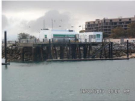
Está diseñado para proporcionar los servicios de diesel y gasolina magna, mide 30 mts. de longitud en su frente principal, las capacidades de los tanques es de 20 mil litros.
