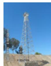
Baliza Escollera Norte:- Torre troncopiramidal metálica de 7 m de altura con características luminosas DR en un periodo de 5.0 seg. Alcance geográfico de. 8 M y luminoso de 7 M.
