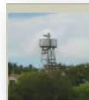
**BALIZA PUNTA BUSTOS LAGUNA DE TAMIAHUA** ubicada en situación geográfica (21° 59' 57.62" N, 97° 43' 56.13" W) , 1 D.B. Período 5.0 seg. Luz 0.5 Ec 4.5, Torre troncopiramidal de conc reto de 5.50 mts. de altura revestida de azulejo color blanco Linterna de 300 mm. Sistema fotovoltaico.
