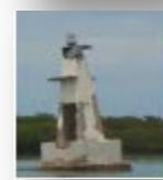
BALIZA TANTALAMOS LAGUNA DE TAMIAHUA, ubicada en situación geográfica (21° 20' 15.94" N, 97° 26' 54.95" W), 3 D.B. Período 12.0 seg. Luz 1.0 Ec 2.0 Luz 1.0 Ec 2.0 Luz 1.0 Ec 5.0, Torre tubular de fibra de vidrio de 5.50 mts. de altura pintada a franjas blancas y naranjas Linterna de 155 mm. Sistema fotovoltaico.
