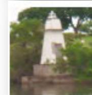
**BALIZA PUNTA MANGLES LAGUNA DE TAMIAHUA** ubicada en siatucion geográfica (22° 55' 00.43" N, 97° 42' 02.41" W), 1 D.B. Período 5.0 seg. Luz 0.5 Ec 4.5, Torre troncopira midal de concreto de 5.50 mts. de altura color blanco. Linterna 300 mm. Sistema fotovoltaico.
