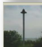
BALIZA SAN JERONIMO SUR LAGUNA DE TAMIAHUA, ubicada en situación geográfica (21°31'21.90" N, 97°36'25.47" W), 1 D.V. Período 5.0 seg. Luz 0.5 Ec 4.5 Torre troncopiramidal de concreto de 5.50 mts. de altura color blanco Linterna 300 mm. Sistema fotovoltaico.
