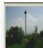
BALIZA RANCHO DE HAMBRES LAGUNA DE TAMIAHUA, ubicada en situación geográfica (21°28'51.41" N, 97°23'47.99" W), 1 D.B. Período 3.0 seg. Luz 0.5 Ec 2.5, Torre troncopiramidal de concreto de 7.0 mts. de altura de color blanco con miras diurnas de color naranja Linterna de 300 mm. Sistema fotovoltaico.
