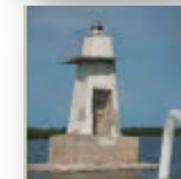
**BALIZA PUNTA MORALES LAGUNA DE TAMIAHUA**, ubicad en situación geográfica (21° 46' 48.36" n, 97° 57' 16.57" W), 1 D.B. Período 5.0 seg. Luz 0. 5 Ec 4.5, Torre troncopiramidal de concreto de 5.50 mts. de altura color blanco Linterna 300 mm. Sistema fotovoltaico.
