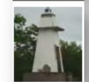
**BALIZA BAJO DE BURROS LAGUNA DE TAMIAHUA**, ubicada en situación geográfica (21° 42' 45.26" N, 97° 34' 13.51" W), 2 D.B. Período 10.0 seg. Luz 1.0 Ec 1.0 Luz 1.0 Ec 7.0, Torre tubular de fibr a de vidrio de 5.50 mts. de altura pintada a franjas blancas y naranjas Linterna 155 mm. Sistema fotovoltaico.
