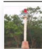
BALIZA MARTINICA LAGUNA DE TAMIAHUA, ubicada en situación geográfica, (22° 41' 12.76" N, 97° 34' 45.36" W ), 1 D.B. Período 3.0 seg. Luz 1.0 Ec 2.0, Torre troncopiramidal de concreto de 5.50 mts. de altura Linterna 300 mm. Sistema fotovoltaico.
