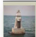
BALIZA ESTERO DE CUCHARAS LAGUNA DE TAMIAHUA, ubicada en situación geográfica (22°37'50.59" N, 97°38'16.53" W), 1 D.B. Período 5.0 seg. Luz 0.5 Ec 4.5, Torre troncopiramidal de concreto de 5.50 mts. de altura color blanco Linterna de 300 mm. Sistema fotovoltaico.
