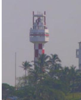
Sobre la margen derecha del río Coatzacoalcos, es notable la Torre de Control de Tráfico Marítimo de forma cilíndrica, de 40 m de altura y pintada de blanco con franjas rojas. Durante la noche está iluminada con luces blancas en su base y rojas en la parte superior. Cuenta con radar de 25 MN, de alcance.
