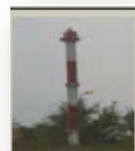
BALIZA ARRECIFE BLANQUILLA. A 7.5 MILLAS NOROESTE DE ISLA DE LOBOS, ubicada en situación geográfico (21° 32' 58.06" N, 97° 16' 44.47" W), 1 D.B. Período 6.0 seg. Luz 1.0 Ec 5 .0, Torre troncopiramidal de concreto de 9.50 mts. de altura pintada de color naranja Linterna de 300 mm. Sistema fotovoltaico.
