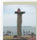
FARO ISLA DE LOBOS SUROESTE DE LA ISLA, ubicada en situación ( 20° 28' 06.46" N, 97° 13' 38.07" W), 1 D.B. Período 3.0 seg. Luz 0.5 Ec 2.5 Torre troncocónica de concreto de 30.0 mts. de a ltura de color blanco Óptica giratoria de 250 mm. Plantas Motogeneradoras.
