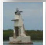
BALIZA TANTALAMOS LAGUNA DE TAMIAHUA, ubicada en situación geográfica (21° 20' 15.94" N, 97° 26' 54.95" W), 3 D.B. Período 12.0 seg. Luz 1.0 Ec 2.0 Luz 1.0 Ec 2.0 Luz 1.0 Ec 5.0, Torre tubular de fibra de vidrio de 5.50 mts. de altura pintada a franjas blancas y naranjas Linterna de 155 mm. Sistema fotovoltaico.
