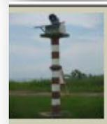
BALIZA ENFILACION POSTERIOR MARCA CANAL ISLA DE LOBOS, se ubica en situación geográfica (2 1° 28' 20.89" N, 97° 13' 32.46" W), 1 D.B. Período 2.0 seg. Luz 1.0 Ec 1.0, Torre tubular de fibra de vidrio de 5 mts. de altura pintada a franjas blancas y naranjas. Linterna direccional de 155 mm. Sistema fotovoltaico.
