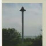
BALIZA SAN JERONIMO SUR LAGUNA DE TAMIAHUA, ubicada en situación geogrífica (21°31'21.90" N, 97°36'25.47" W), 1 D.V. Período 5.0 seg. Luz 0.5 Ec 4.5 Torre troncopiramidal de concreto de 5.50 mts. de altura color blanco Linterna 300 mm. Sistema fotovoltaico.
