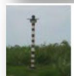
BALIZA POZO ISLA DE LOBOS, se ubica en situación geográfica (21° 28' 38.50" N, 97° 13' 15.26" W), 1 D.B. Período 3.0 seg. Luz 0.5 Ec 2.5 Torre con base troncopiramidal de concreto de 3.60 mt s. de altura y tubo PVC 6" de diámetro relleno de concreto Linterna de 155 mm.Sistema fotovoltaico.
