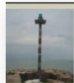
BALIZA EL COCAL BARRA DE CORAZONES, se ubica en situación geográfica (21° 15' 38.98" N, 97° 26' 05.78" W), 1 D.B. Período 3.0 seg. Luz 1.0 Ec 2.0, Torre cilíndrica de concreto de 3.50 mts. de altura y 10" de diámetro. Linterna 300 mm. Sistema fotovoltaico.
