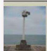
BALIZA ESCOLLERA NORTE BARRA DE CORAZONES, se ubica en situación geográfica (21° 15' 38.02" N, 97° 25' 06.3 2" W); 1 D.R. Período5.0 seg. Luz 0.5 Ec 4.5, Torre troncopiramidal metálica de 7.0 mts. de altura de color blanco con miras diurnas color naranja Linterna de 300 mm. Sistema fotovoltaico.
