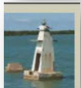
BALIZA GUAYABALILLO LAGUNA DE TAMIA HUA, ubicada en situación geográfica (21° 21' 06.32" N, 97° 26' 58.13" W), 1 D.B. Período 6.0 seg. Luz 1.0 Ec 5.0, Torre troncopiramidal de concreto de 5.50 mts. de altura revestida de azulejo blanco Linterna de 300 mm. Sistema fotovoltaico.
