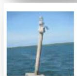
BALIZA RESTINGA DE ORO LAGUNA DE TAMIAHUA, ubicada en situación geográfica (21° 23' 50.54" N, 97° 26' 40.11" W), 1 D.B. Período 6.0 seg. Luz 1.0 Ec 5.0, Torre troncopiramidal de concreto de 5.50 mts. de altura revestida de azulejo blanco Linterna de 300 mm. Sistema fotovoltaico.
