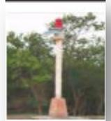
BALIZA MARTINICA LAGUNA DE TAMIAHUA, ubicada en situación geográfica, (22° 41' 12.76" N, 97° 34' 45.36" W ), 1 D.B. Período 3.0 seg. Luz 1.0 Ec 2.0, Torre troncopiramidal de concreto de 5.50 mts. de altura Linterna 300 mm. Sistema fotovoltaico.
