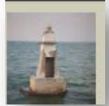
BALIZA ESTERO DE CUCHARAS LAGUNA DE TAMIAHUA, ubicada en situa ción geográfica (22°37'50.59" N, 97°38'16.53" W), 1 D.B. Período 5.0 seg. Luz 0.5 Ec 4.5, Torre troncopiramidal de concreto de 5.50 mts. de altura color blanco Linterna de 300 mm. Sistema fotovoltaico.
