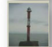
BALIZA LA LAJA LAGUNA DE TAMIAHUA, ubicada en situación geográfica, (22° 42' 14.55" N, 97° 41' 19.07" W), 1 D.R. Período 6.0 seg. Luz 1.0 Ec 5.0, Torre troncopiramidal de concreto de 5.50 mts. de altura pintada de color blanco con miras diurnas Linterna 300 m. Sistema fotovoltaico.
