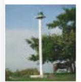
BALIZA ESTERO DE TANCOCHIN LAGUNA DE TAMIAHUA, ubicada en situación geográfica (21°28'32.99" N, 97°31'01.04" W), 2 D.B. Período 10.0 seg. Luz 1.0 Ec 2.0 Luz 1.0 E c 6.0, Torre troncopiramidal metálica de 7.0 mts. de altura de color blanco Linterna 300 mm. Sistema fotovoltaico.
