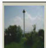
BALIZA RANCHO DE HAMBRES LAGUNA DE TAMIAHUA, ubicada en situación geográfica (21°28'51.41" N, 97°23'47.99" W), 1 D.B. Período 3.0 seg. Luz 0.5 Ec 2.5, Torre troncopiramidal de concreto de 7 .0 mts. de altura de color blanco con miras diurnas de color naranja Linterna de 300 mm. Sistema fotovoltaico.
